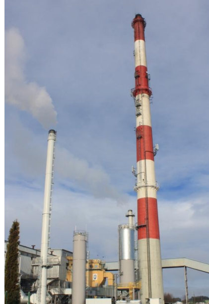
Widok ciepłowni,, fot. z archiwum PEC w Suwałkach Sp. z o.o.
